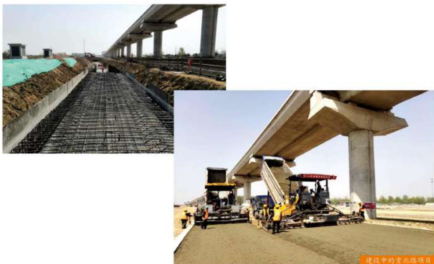
建设中的贡北路项目
